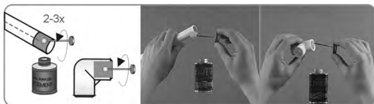
Рис. 27. Нанесение клея на склеиваемые элементы
